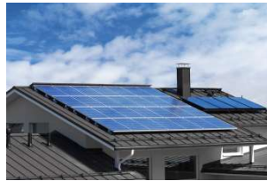
Şəkil 3. Damda günəş panellərinin quraşdırılması
