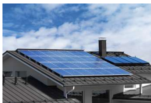
Şəkil 3. Damda günəş panellərinin quraşdırılması
