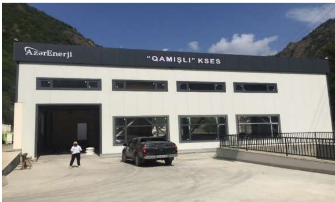
Şəkil 4. Qamışlı Kiçik Su Elektrik Stansiyasının (KSES) binasının ümumi görünüşü
